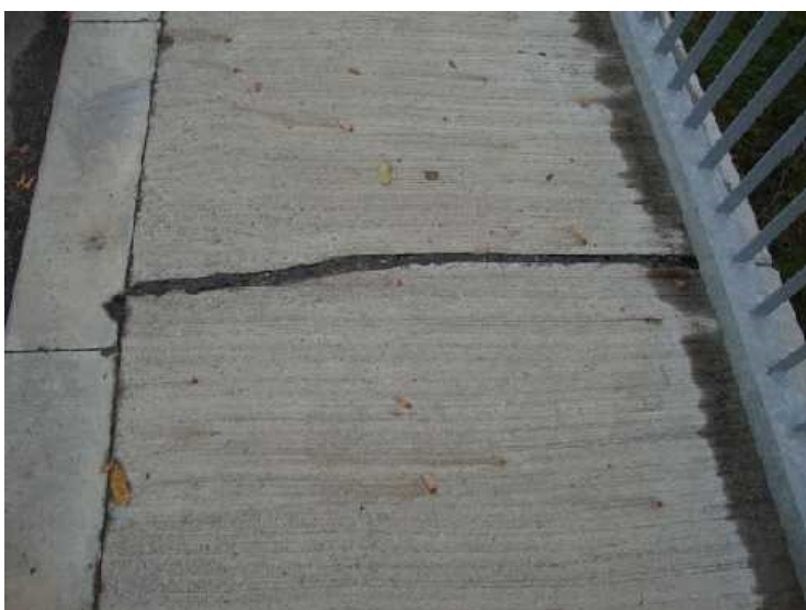
Obr. 8: Trhlina zalitá živičnou zálivkou.
