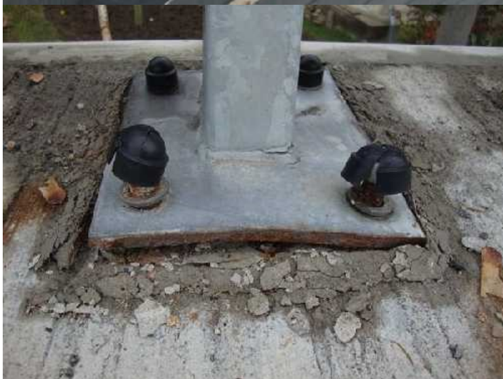
Obr. 11: Poškozené kotvení sloupku zábradlí.
