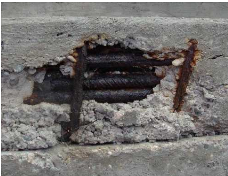
Obr. 22: Koroze dolní stěny prefabrikátu NK.
