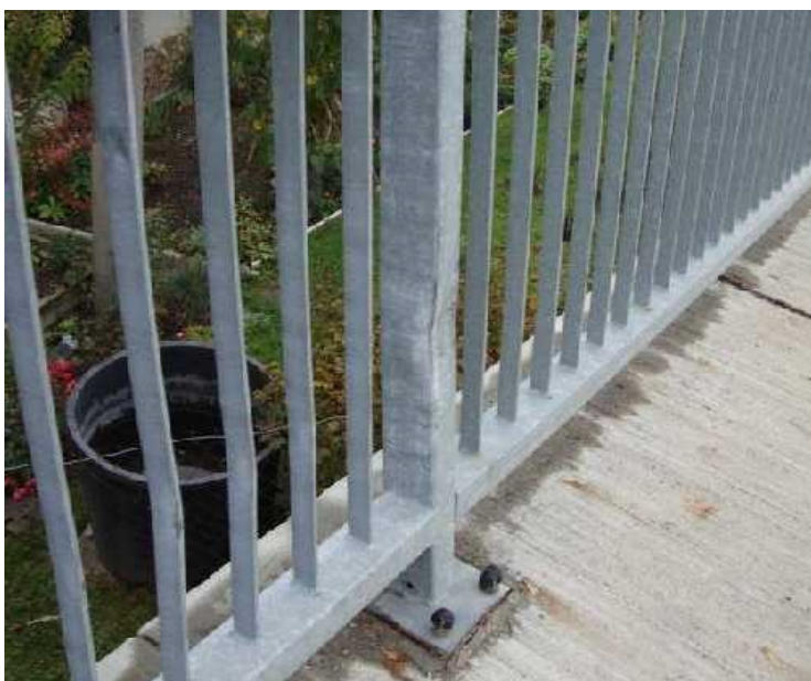
Obr. 9: Nabouraný sloupek zábradlí.
