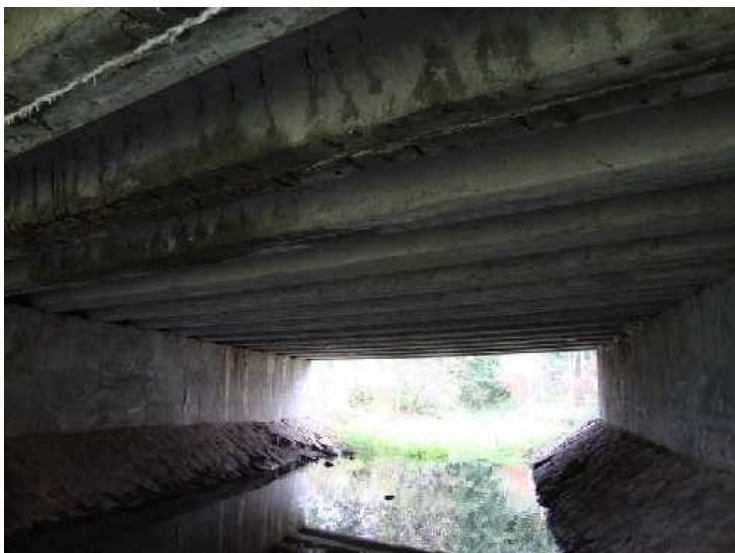
Obr. 19: Zatékání, nedostatečné krytí.
