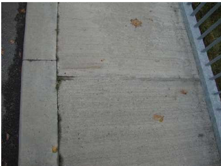
Obr. 7: Detail smršťovací spáry.
