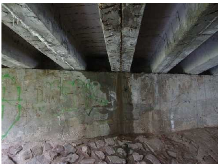
Obr. 17: Výrony vody na opěře.
