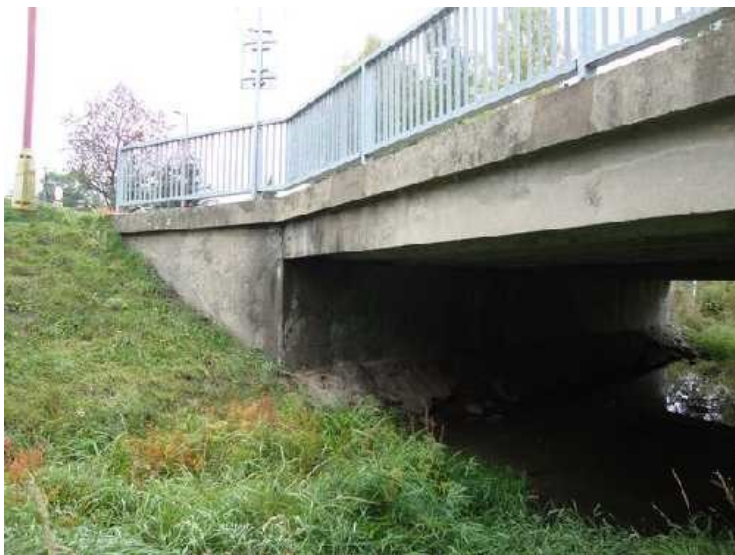
Obr. 13: Levostranná opěra a křídlo.
