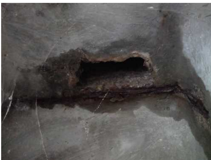
Obr. 23: Díra v horní desce NK, zatékání.
