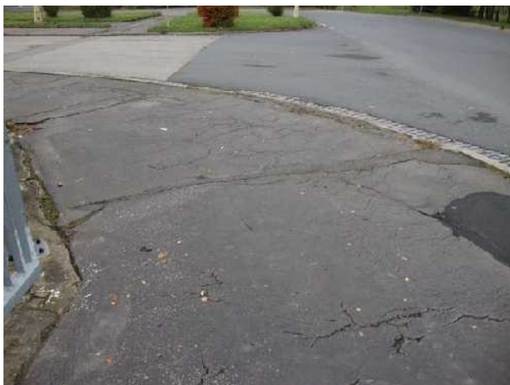
Obr. 3: Chodník s živicí s četnými trhlinami.
