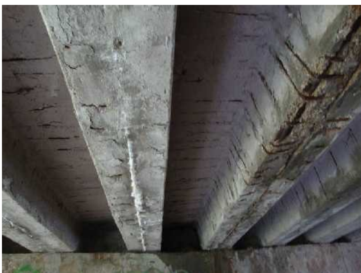
Obr. 20: Zatékání, koroze výztuže, absence krytí.
