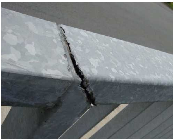
Obr. 10: Trhlina mezi sloupkem a madlem zábradlí.
