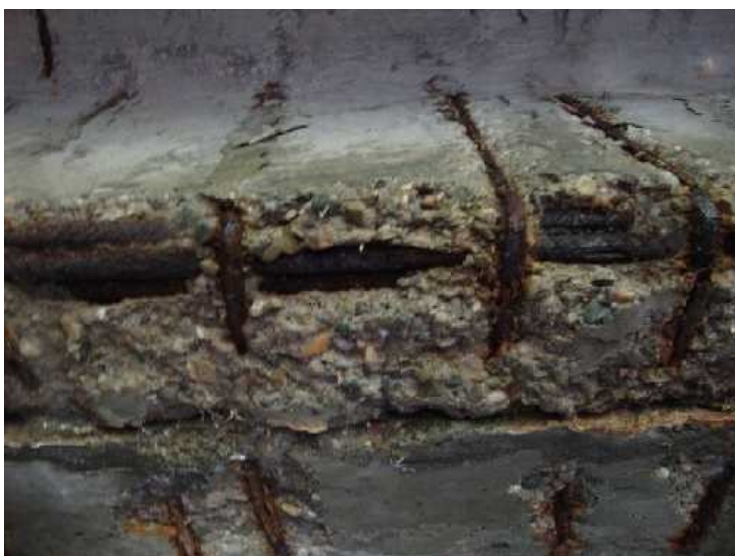
Obr. 21: Koroze dolní stěny prefabrikátu NK.
