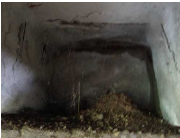
Obr. 24: Sypký materiál vypadává dírou v NK.
