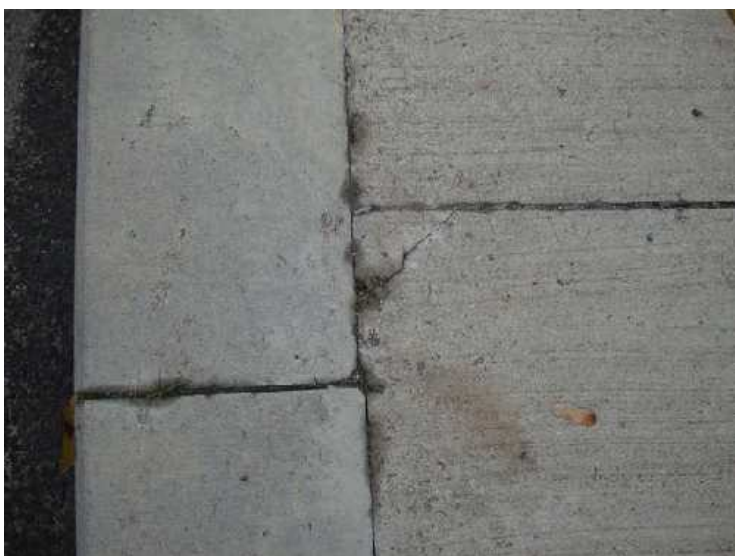
Obr. 6: Detail spáry mezi bet. obrubníkem a monolitickou římso.
