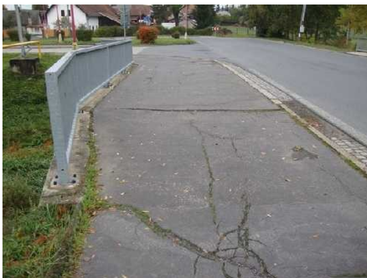
Obr. 2: Chodník s živicí s četnými trhlinami.
