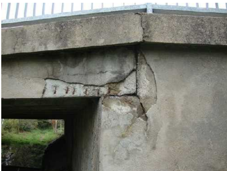
Obr. 15: Detail uložení, trhлина v úložném prahu.
