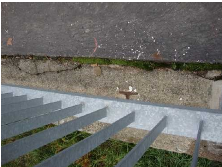
Obr. 4: Původní sloupek v zábradlí v římse, zarostlá spára.
